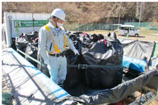
除去土壌等の積み出し工事
