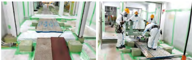
運搬用スロープ
