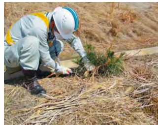
堰堤に生えた樹木の除去
