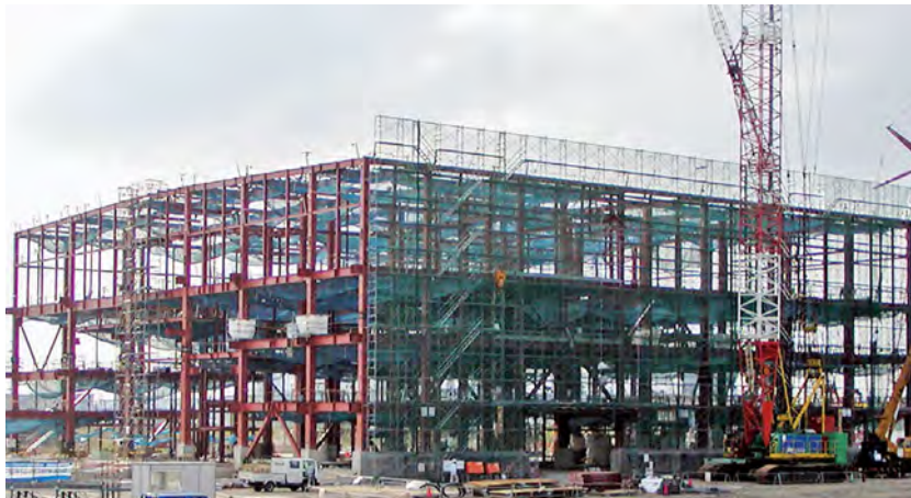
北九州事業（第1期）処理施設建設施工の様子（当時）
