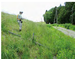
通常点検の様子
