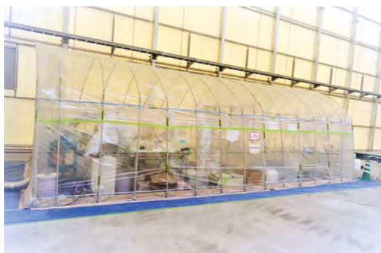
国立環境研究所にて、飛灰の混練作業を実施（管理区域）
