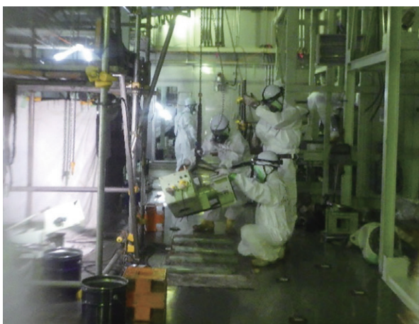
裁断破碎エリアの解体撤去の状況
