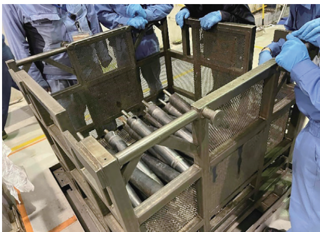
真空超音波洗浄設備後の解体撤去物
