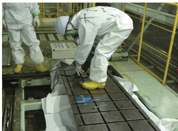
小型トランス解体エリアの解体撤去の状況
