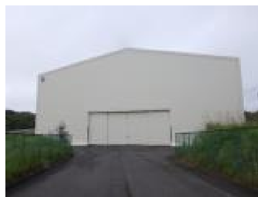
No.4 陣場沢灰処理生成物保管設備cS⑥
