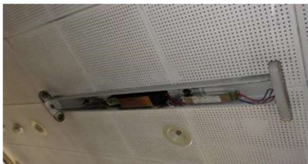
事例 4 : LED 化工事後に残置された安定器
