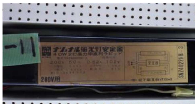
事例 4 : LED 化工事後に残置された安定器
