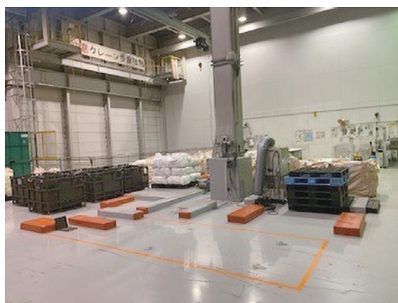
紙類梱包機解体撤去後の払出エリア
