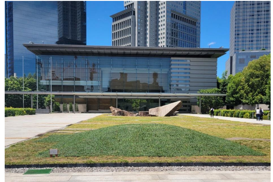
施工後の様子
