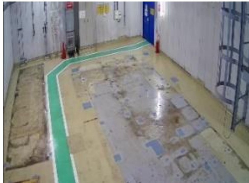
囲い室の解体撤去後
