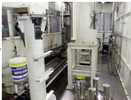
囲い室内 (除去分別中)
