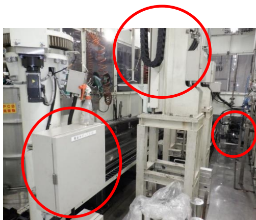
囲い室内 (除去分別前)
