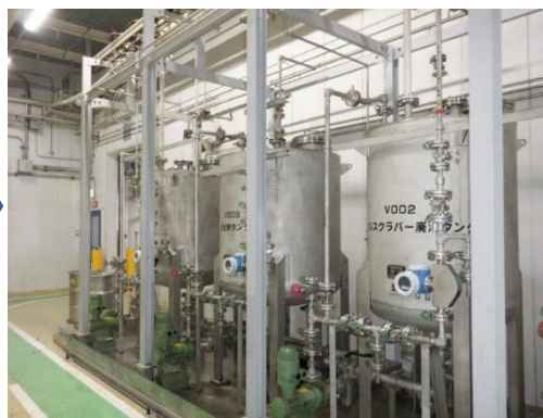
タンク類(除去分別中)
