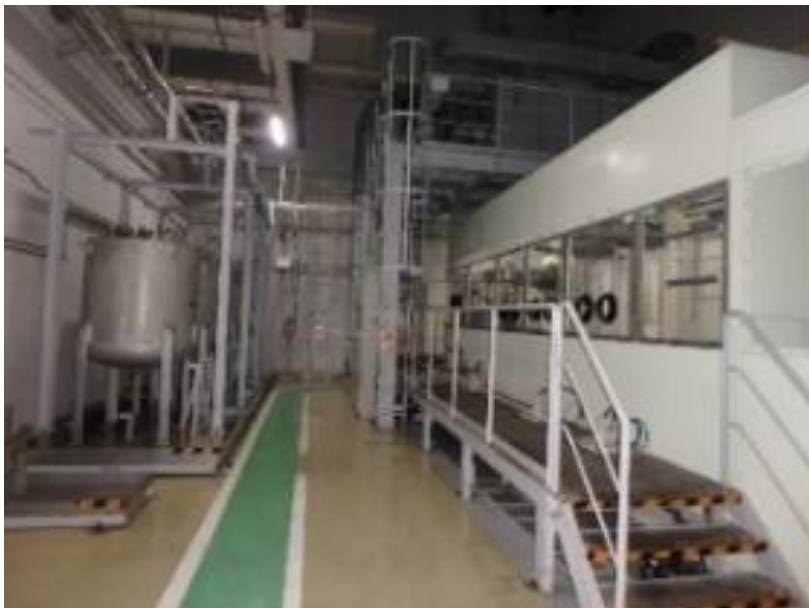
囲い室の解体撤去前
