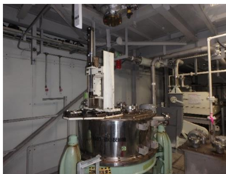
No.1遠心脱油機 配管類取外し後
