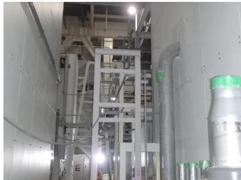
配管類取り外し後
