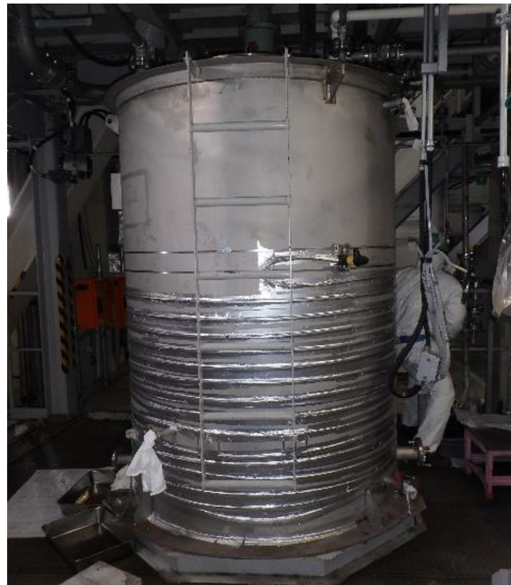
配管類取り外し後
