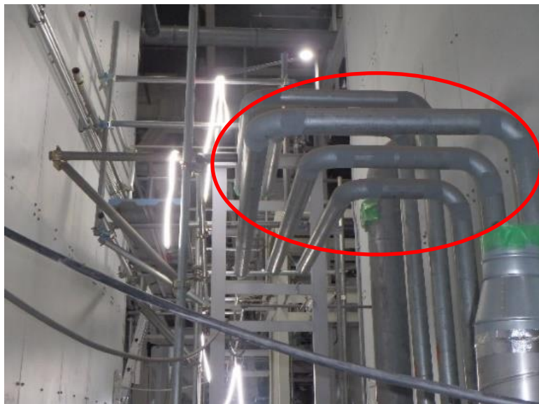
配管類取り外し前
