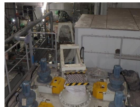
素子回収コンベア 取外し後
