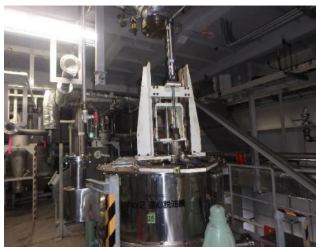
No.2遠心脱油機 配管類取外し後
