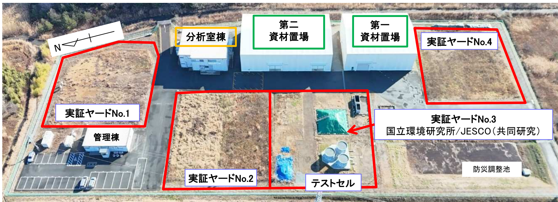
ドローンによる技術実証フィールド全景(2025年1月7日時点)
