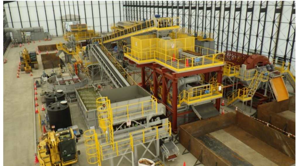
<実証設備全景>
