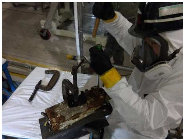
小型コンデンサーの取り出し作業
