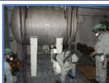
廃アルカリ分解槽（解体前）
