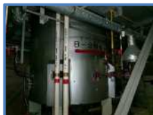
分解槽（解体前）
