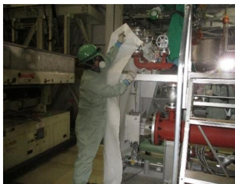
熱媒ユニットの搬出・撤去
