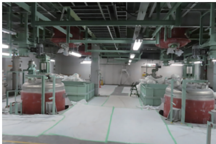
液処理室タンク保温撤去
