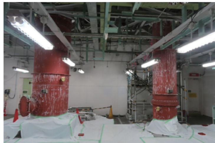
溶剤蒸留回収室 塔保温撤去
