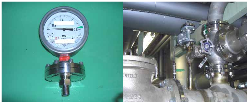
図 3-1 脱落した圧力計
