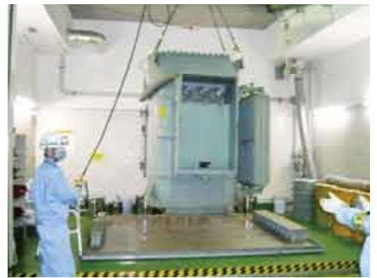
大型トランスを清掃解体室へ移動する様子
