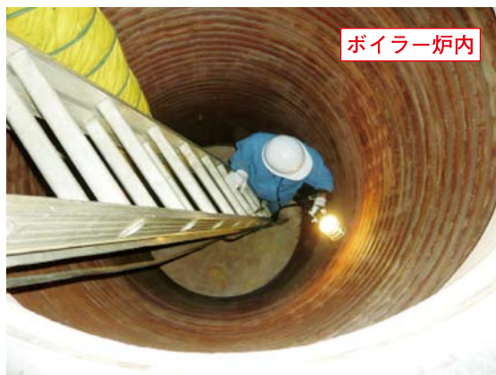
ボイラー・第一種圧力容器性能検査の様子
