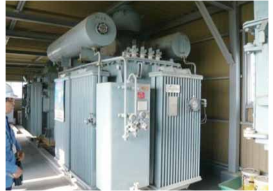
超大型トランスの現地調査の様子 (総重量13.75t、油量4,180L)
