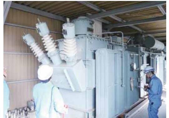
この大型トランスは、総重量11.5t、油量3,260L
