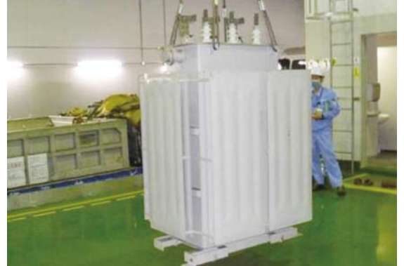
受け入れた大型トランス(総重量1,700kg)
