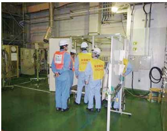
受入エリアにおける安全パトロールの様子
