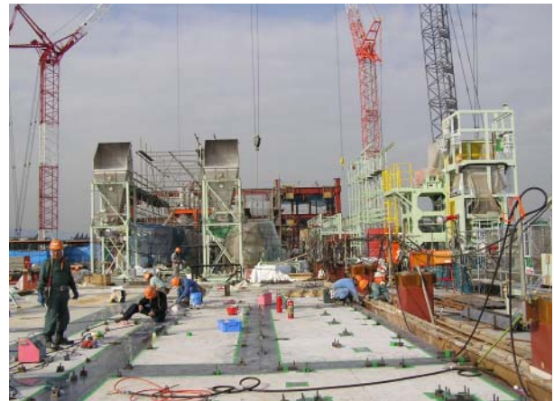
4階機器の設置状況
