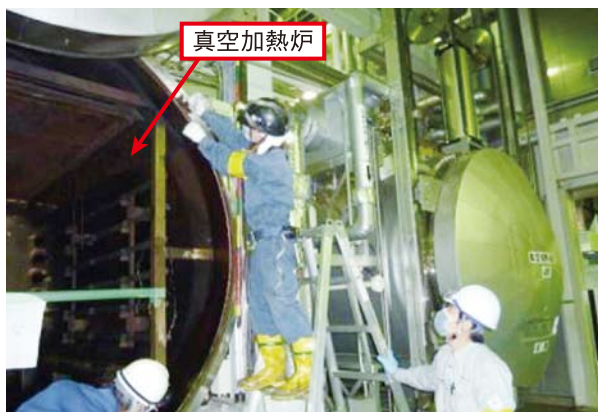
真空加熱炉の扉リング(パッキン)の交換
