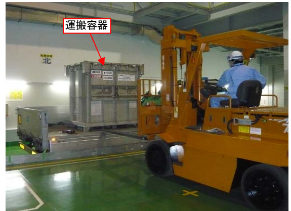
運搬容器に収納された小型トランスの受入
