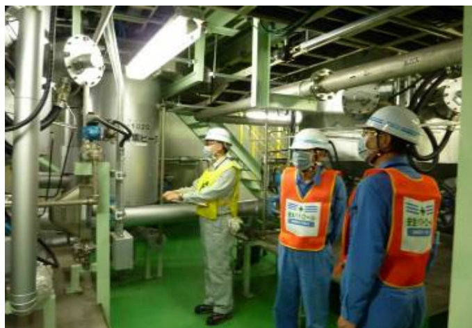
安全パトロールの様子
