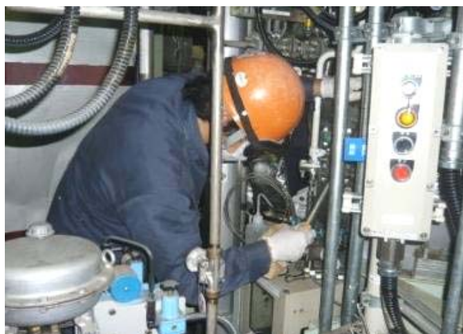
真空加熱設備 副反応槽レベル計の点検清掃
