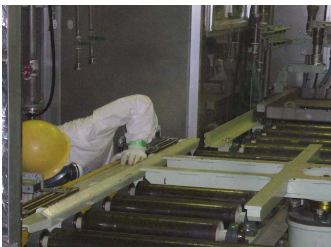
小型トランス解体エリア コンベアのメンテナンス
