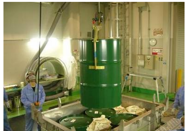
PCB油が入っているドラム缶の取り出し
