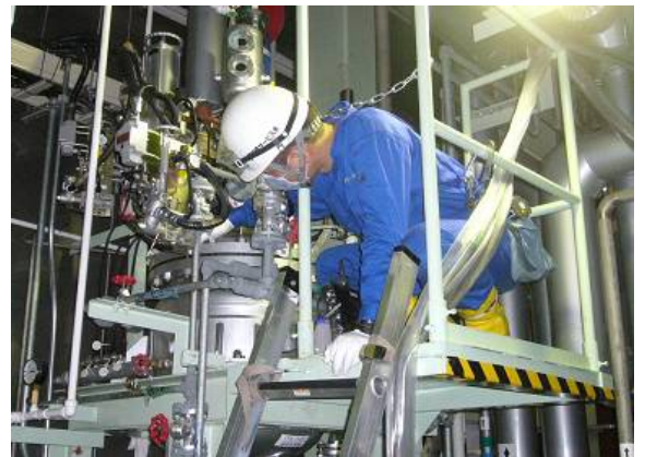
前回の定期点検の様子 (後処理槽の肉厚検査)
