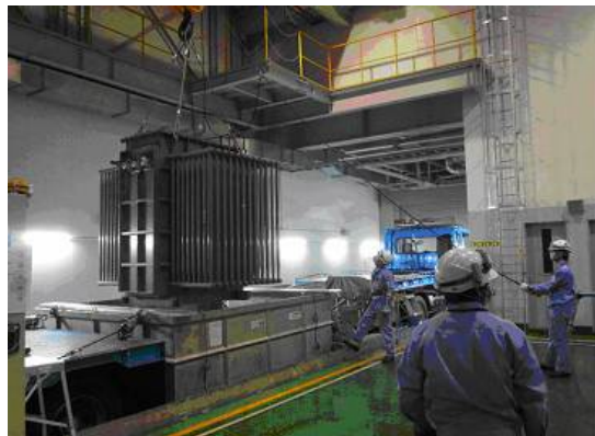
大型トランス(約10トン)の搬入
