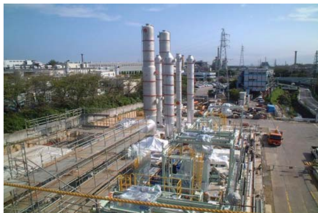
蒸留塔据付状況
