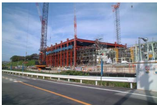
建築鉄骨建方状況
