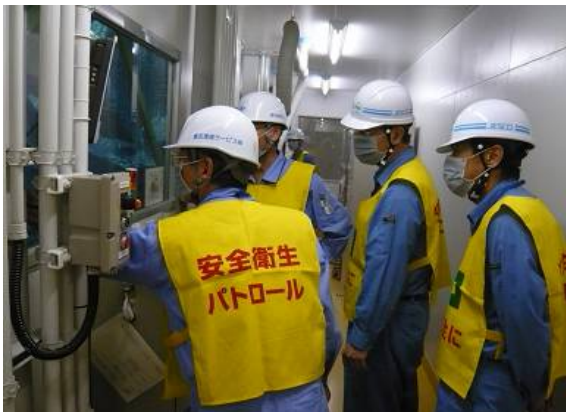
解体エリアにおける安全パトロール
