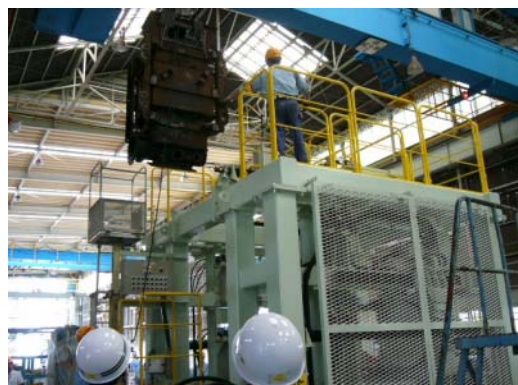
切断機(横型バンドソー)に車載トランスを搬入
