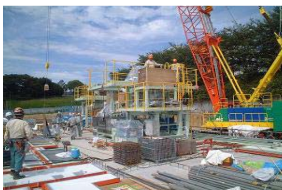
コンデンサ解体ライン抜油装置据付状況
