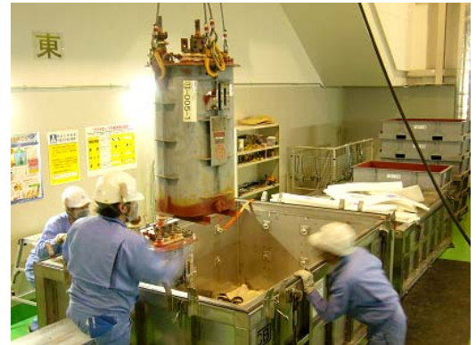
小型トランスの検査確認 (収集運搬時にPCBの漏洩がなかったか等を確認)
