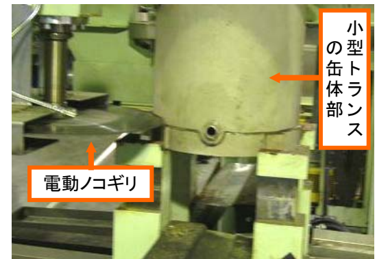
解体設備内における小型トランスの切断状況
