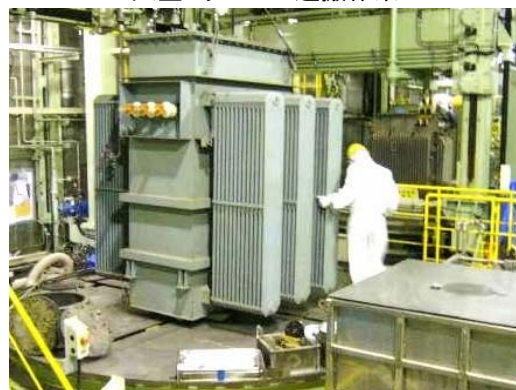
大型トランスの解体準備作業
