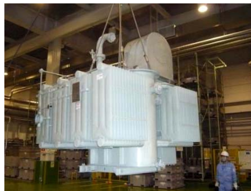
大型トランスの運搬作業
