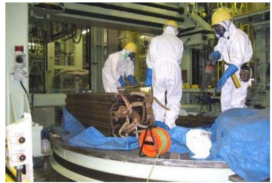
運転再開後の作業状況(トランス解体)
