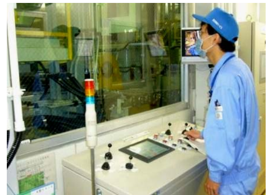
運転再開前の作動確認
