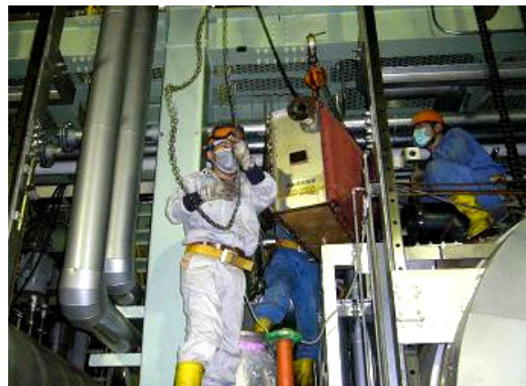
冷却器の取り外し(この後詳細調査へ)
