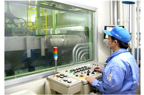
遠隔操作による小型トランス解体作業
