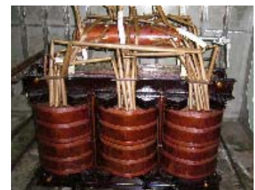
大型トランスコア部取出し
