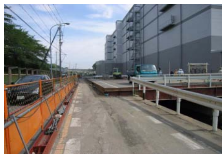
仮設橋撤去工事の状況
