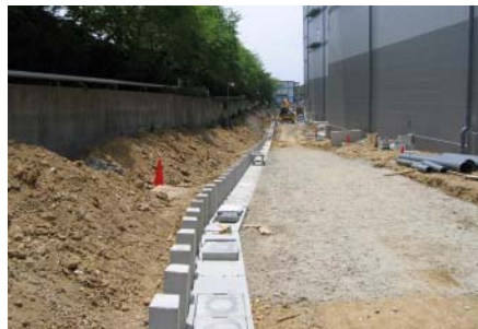
外周道路側溝の工事状況
