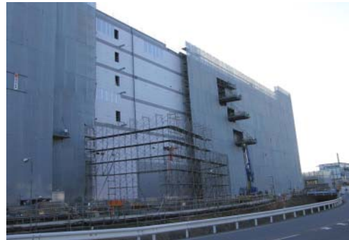
外壁塗装が一部完了した処理棟西面
