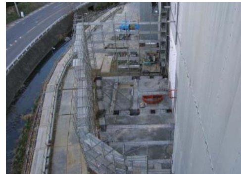
基礎工事が完了したSD受入室・ボイラー置き場
