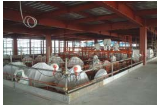
液処理設備機器設置状況(7階)
