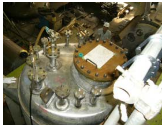
液処理反応槽に仮蓋をして気密テスト
