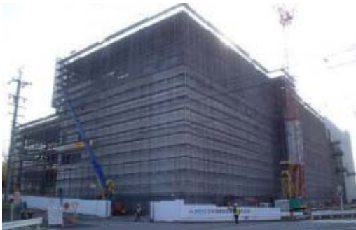
建物が上棟した現在の状況
