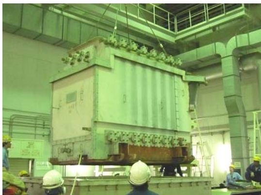
搬入された超大型トランス
