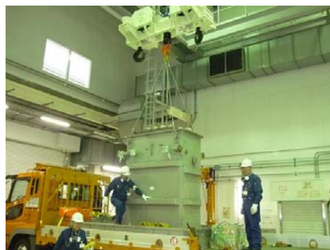
抜油済大型トランス搬入の様子
