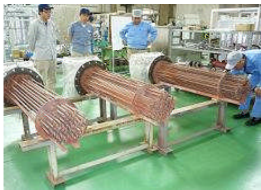
電気ボイラーのヒーター管束洗浄後の検査風景
