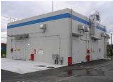
危険物庫外観
