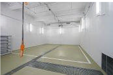
危険物庫内部
