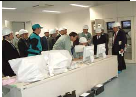
現場視察(西棟中央制御室)
