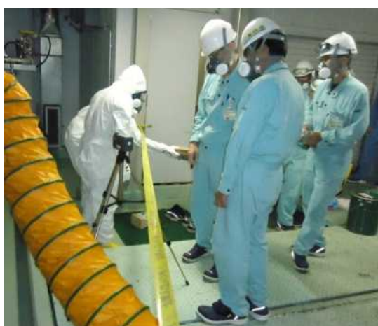
局所排気及び防護服等の着用
