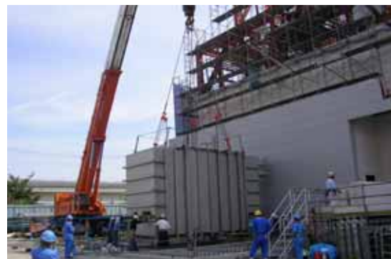
外殻構造体付きタンク据え付け状況
