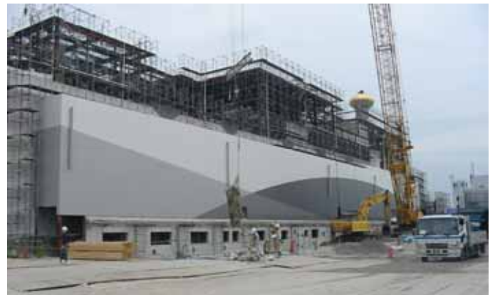
外壁パネルの取り付け状況（西区画棟）
