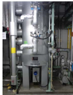
改善された排気処理設備の中心となる吸収塔(左)と活性炭吸着塔
