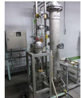
改善された排気処理設備の中心となる吸収塔(左)と活性炭吸着塔
