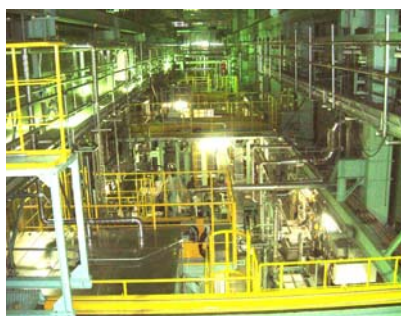
コンデンサ解体エリア
